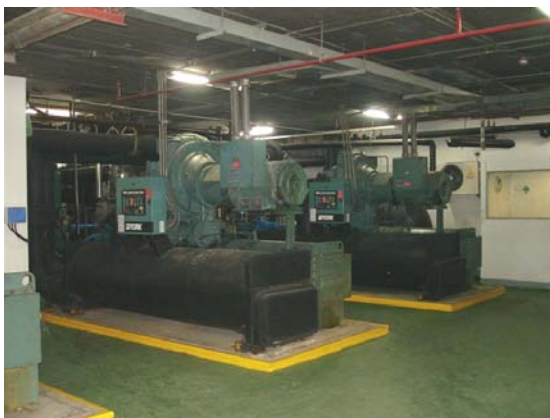
รูปที่ 2.3.10 แสดงเครื่องปรับอากาศแบบระบายความร้อนด้วยน้ำ (Water Cooled Chiller System) ติดตั้งชุดเครื่องทำความเย็น (Chiller) ปั๊มสำหรับเครื่องทำความเย็น (Chiller Pump)
