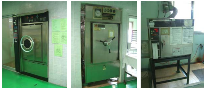
รูปที่ 2.3.8 แสดงหม้อนึ่งอัตโนมัติ (Steam Auto Clave) หรือ เครื่องอบแก๊ส (Gas Sterilizer) ในแผนกจ่ายวัสดุกลางปราศจากเชื้อ (Central Sterile Supply Department; CSSD)
