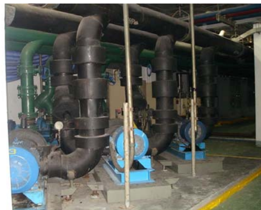
รูปที่ 2.3.10 แสดงเครื่องปรับอากาศแบบระบายความร้อนด้วยน้ำ (Water Cooled Chiller System) ติดตั้งชุดเครื่องทำความเย็น (Chiller) ปั๊มสำหรับเครื่องทำความเย็น (Chiller Pump)
