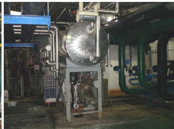
รูปที่ 2.3.11 แสดงเครื่องทำน้ำร้อน (Boiler) และไอน้ำร้อน (Steam Boiler)
