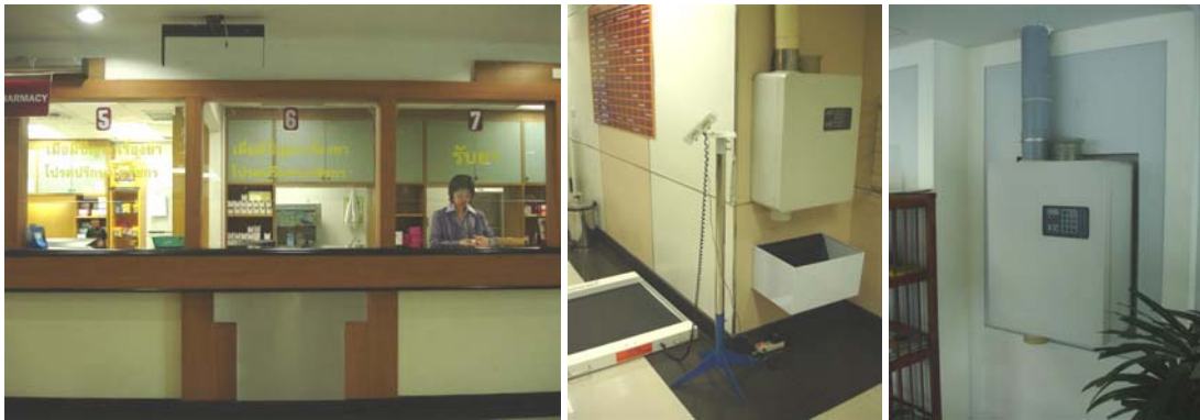
รูปที่ 2.3.5 แสดงแผนกเภสัชกรรม (Pharmacy Department) และท่อส่งเอกสารในการติดต่อกับแผนกอื่นๆ
