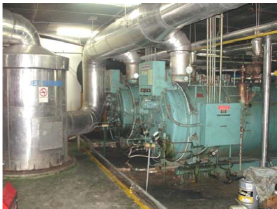
รูปที่ 2.3.11 แสดงเครื่องทำน้ำร้อน (Boiler) และไอน้ำร้อน (Steam Boiler)
